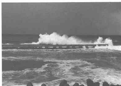
写真-1 吉原新型離岸堤
