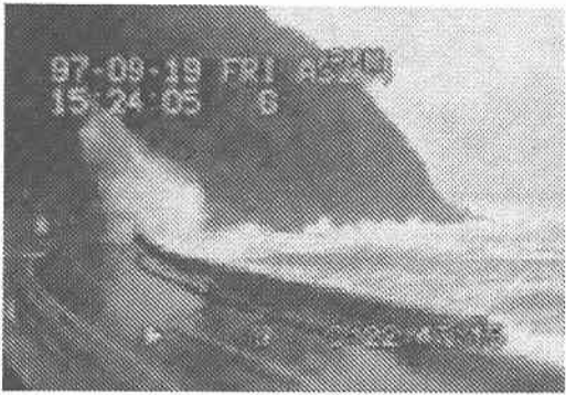
写真-1 現地における越波状況
