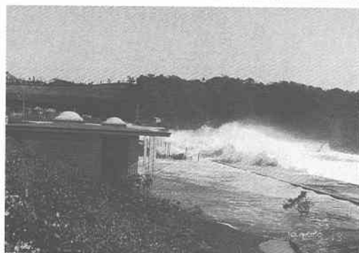
写真一1 台風9720号による越波の状況 (9月19日10:00ごろ撮影)
