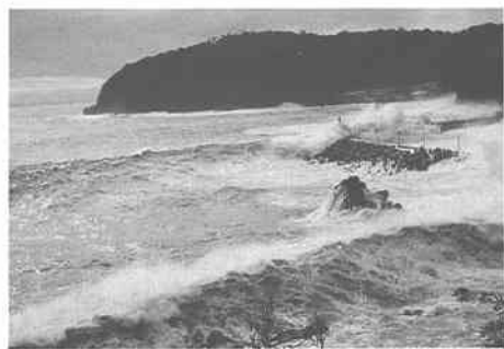
写真-3 真鶴港防波堤の越波状況 (9月19日8時頃)
