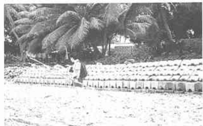
写真-3 最近のコンクリートブロック護岸 (No. 10 地点付近)
