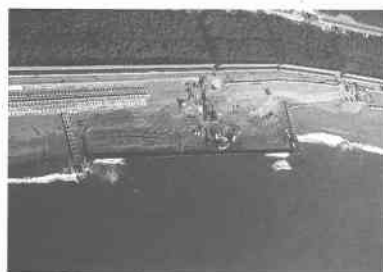
写真-2 BMS工事中の海岸線状況 (1995年12月21日撮影)
