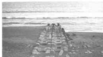
写真-3 3号突堤周辺の汀線状況(1996年6月7日撮影)
