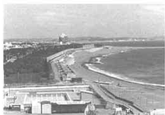
写真-4 茅ヶ崎漁港側からBMS試験区間を望む状況(1996年9月12日撮影)
