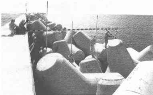
写真-1 串木野新港被災状況 (1991/9)
