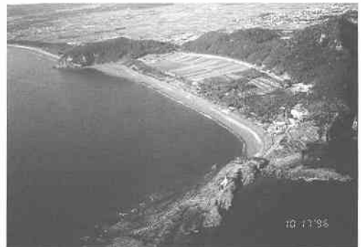
写真-2 長崎鼻海岸の汀線（1996年10月17日撮影）
