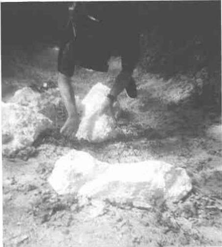
写真-1 基盤用の捨て石と珊瑚塊採掘穴の様子
