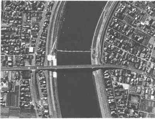
図-3 気泡噴流の現地実験の状況 (手前が天大橋)
