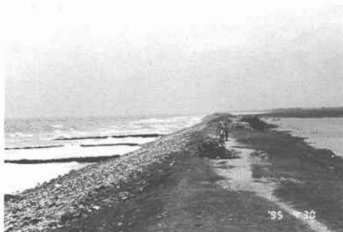
写真-1 海岸堤防と突堤群 (Hai Hau 地区)
