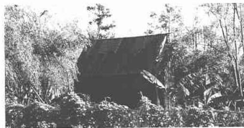
写真-3 下流側の小屋に残る浸水痕跡
