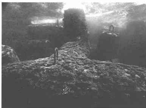
写真-1 サンゴ着生状況（施工後8年目）
