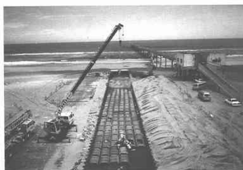
写真-1 透水層施工状況
