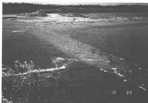
写真-2 干上がった透水層埋設範囲
