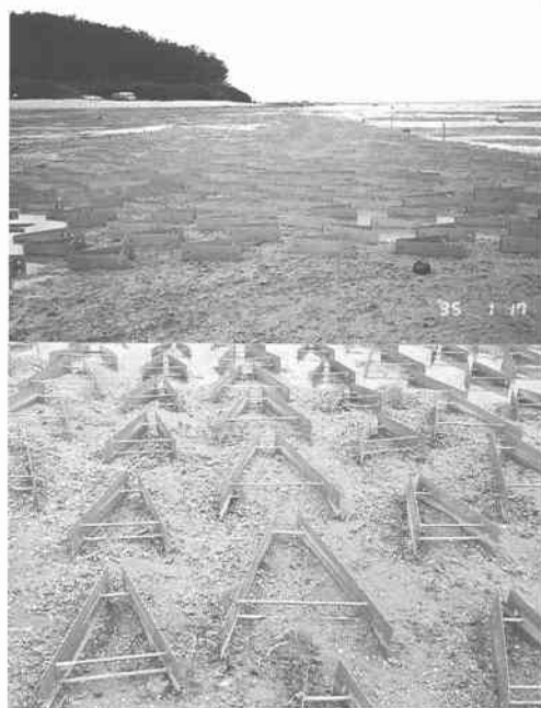
写真-1 ハの字板の設置状況
