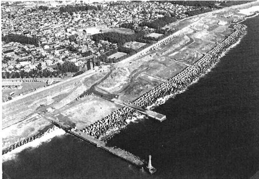
写真-1 田子の浦港の東部の海岸線状況 (1992年2月撮影)
