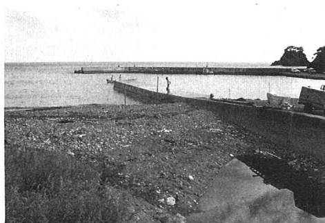
写真-2 常時完全閉鎖している河口
