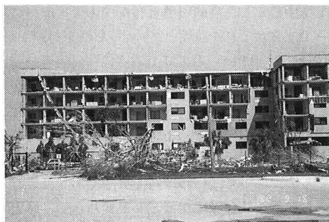
写真-5 疑似コンクリート構造物の被害
