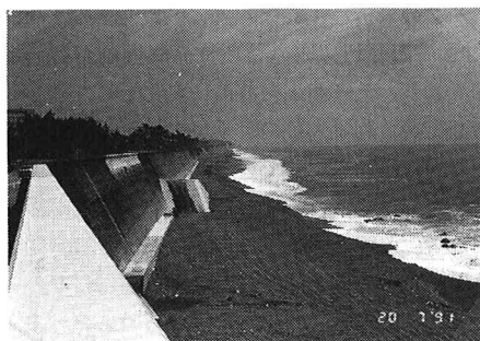
写真-1 被災現場(7月20日、被災前)
