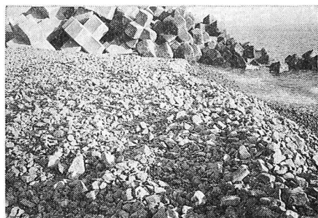
写真-1 B-B' 断面付近における養浜材のうちあがり状況 (1988年12月26日撮影)
