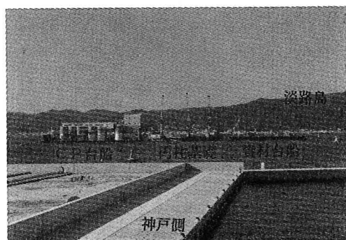
写真-1 現地状況
