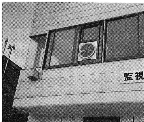
写真-2 観測施設(カメラ収納ケース)
