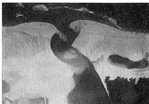
写真一1 河口の空中写真 (1991年2月1日)
