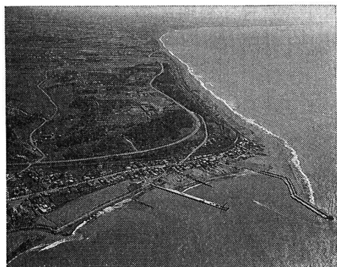
写真-1 門別漁港周辺の海浜状況 (1987年9月29日撮影)
