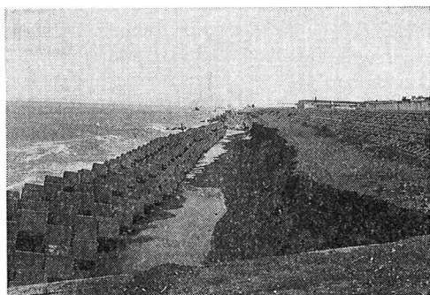
写真-2 横道海岸の変遷 (1985年7月2日撮影)
