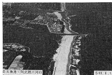
写真-2 荒浜漁港周辺の海岸状況
