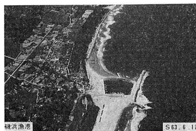
写真-1 磯浜漁港周辺の海岸状況
