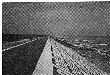
写真-5 岩沼海岸の堤防の状況
