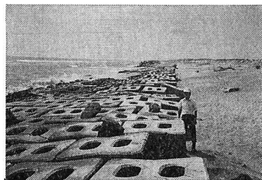
写真-4 岩沼海岸の汀線状況
