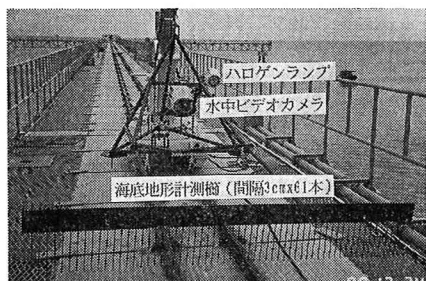
写真-2 海底地形計測櫓と懸架装置
