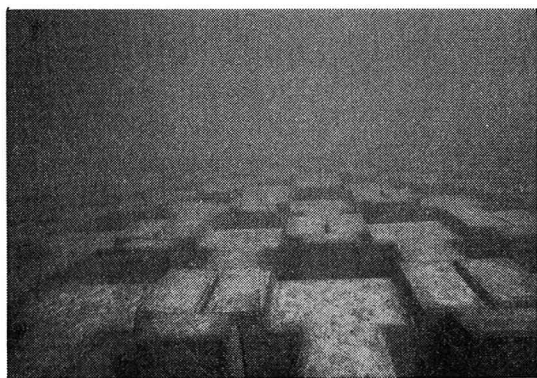
写真-2 複合部材の海底敷設状況
