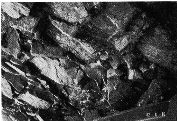
写真-1 アスファルトマットとケーソンの付着状態
