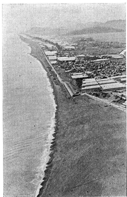
写真一 離岸堤着手前状況 (昭和 48 年 3 月)
