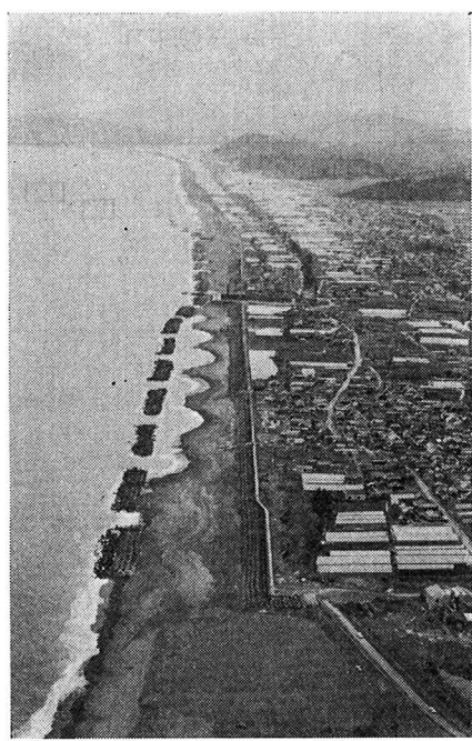
写真二 現 況 (昭和 58 年 3 月)
