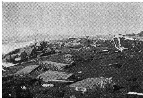
写真-4 被災後(昭和54年10月20日)
