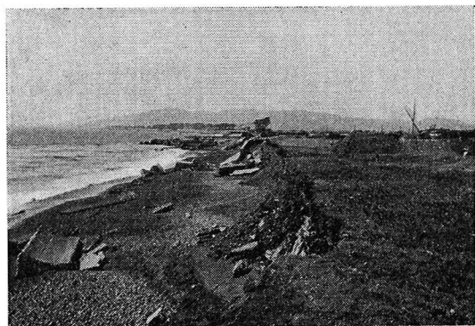
写真-2 高松海岸決壊 (昭和 52 年 3 月)
