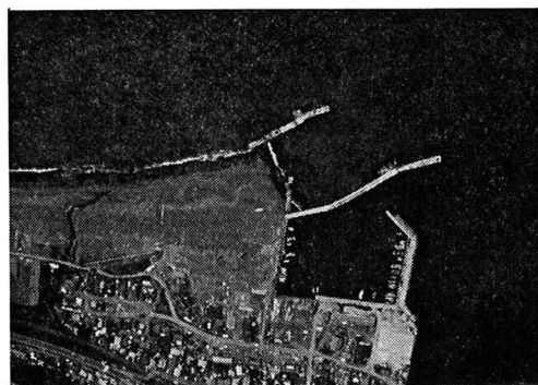
写真-4 節婦漁港(日高海岸)の堆砂状況(51年撮影)
