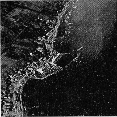
写真-4 港と漂砂移動(釜谷) (48年撮影)
