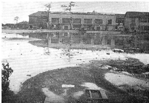
写真—3.2 元吉原小学校の被害状況 (元吉原小学校職員撮影)
