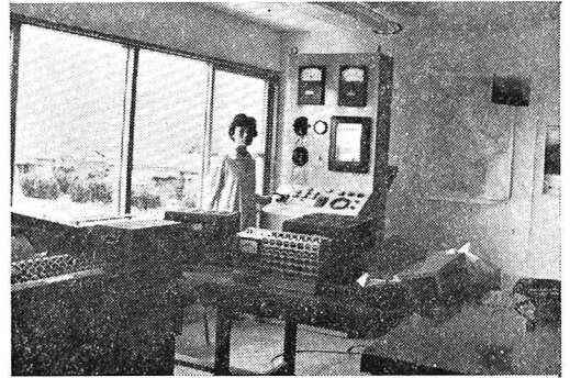
写真-2 操作観測装置
