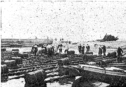
図一八 潮止用コンクリート・ブロック及びその施工状況
