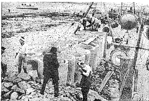
図-10 締切完了の状況
