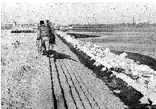
図-11 ビニール袋入り土嚢使用状況
