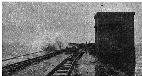
写真 4 被災直前の上部型枠工
