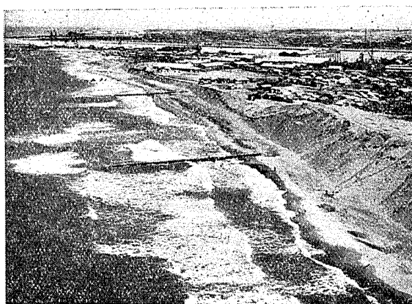
写真-1 新潟西海岸における砂丘の欠損と縦堤の状況
