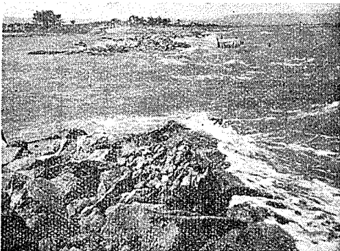
写真 一 4(a) 三重県度会郡東黒部村吹井浦地先、松阪海岸東野部下御糸地区被災當時（建設省委託地区）
