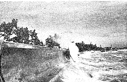
写真 一 5(a) 愛知県知多郡武豊町宇忠白田地先、忠白田海岸堤防完成胸壁を波が越える状況 昭. 29. 6. 22, 9時30分頃；風向 SE；風速 10~15 m/sec.（建設省委託施工区域）
