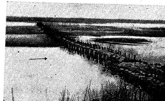
写真第33 杭出し及び合掌枠水制
