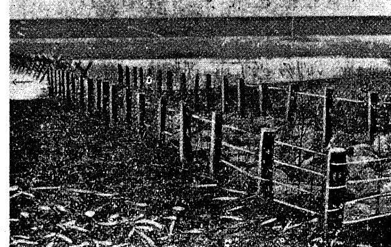
写真第 16 柳挿杭打上置（高水敷床止工）
