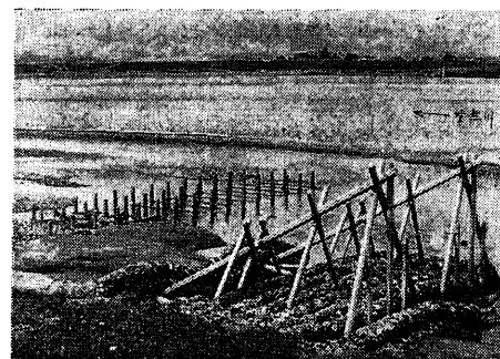
写真第 23 鉄筋材杭出し及び大聖牛
