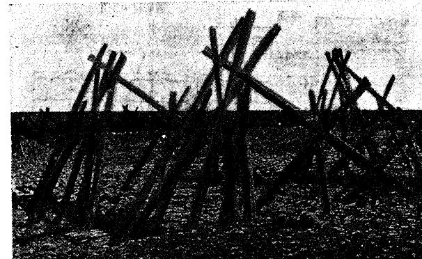
写真第 25 鉄筋材大聖牛(緩衝材として丸太取付)
