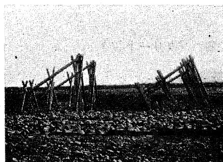
写真第 24 鉄筋材大聖牛(激流を避くるため上手の分の合掌材を傾斜せしむ)
