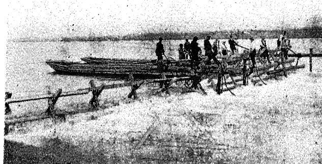
写真第40 鉄筋材合掌枠洗設 上利根川改修
