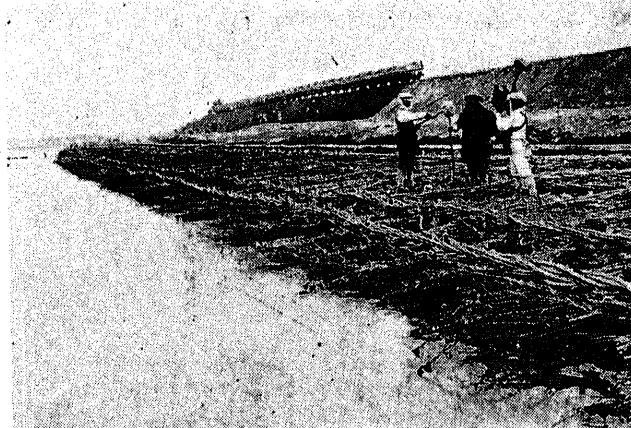
写真第43 粗朶沈床（その一） 中利根川改修
