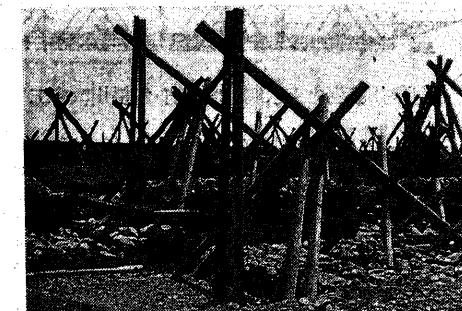
写真第 26 鉄筋材大聖牛(緩衝材として丸太取付)
