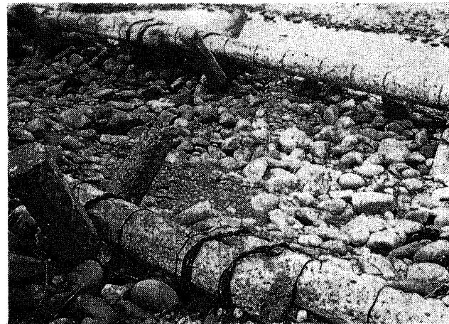
写真第41 鉄筋材合掌枠水制 上利根川改修
