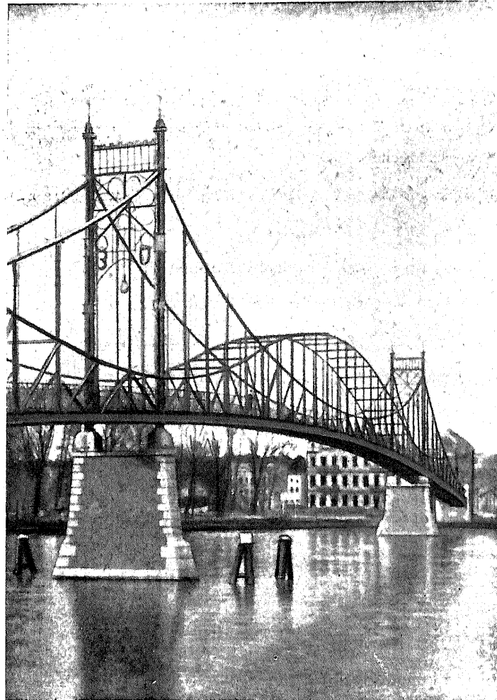
42. ニーダーシェーネワイデの歩道橋
