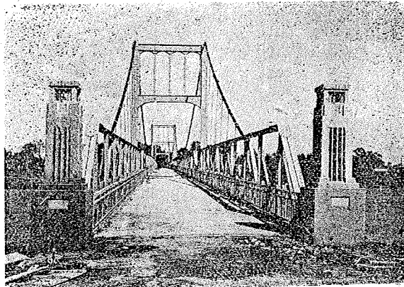
写真 14-2 榮橋 (利根川, 多徑間吊橋)
