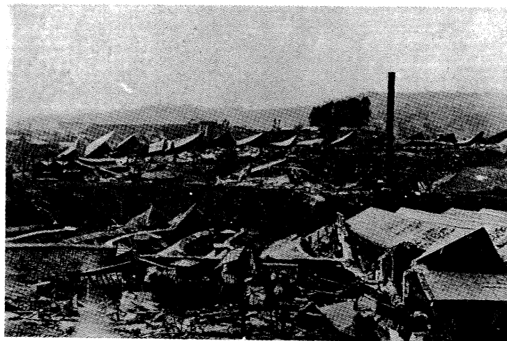
靜岡縣 富士瓦斯紡績株式會社小山一二工場被害狀況
