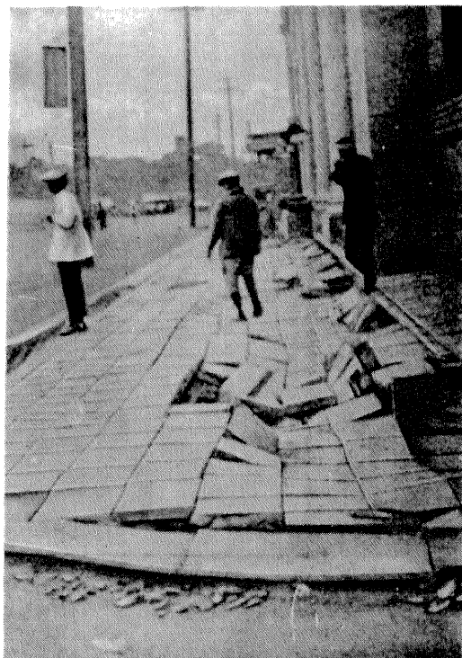
東京市 歩道被害状況(其四) (興業クラブ前)
