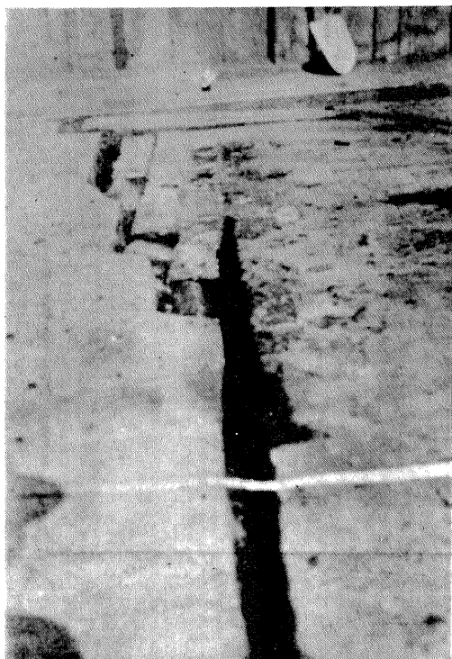
東京市 歩道被害状況(其二) (丸ノ内ビル ディング沿ひ)
