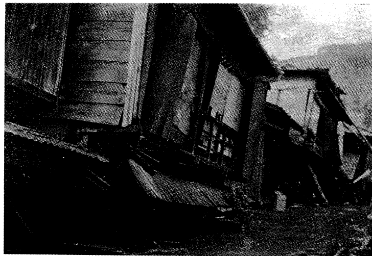
静岡県 小山町役場前被害状況
