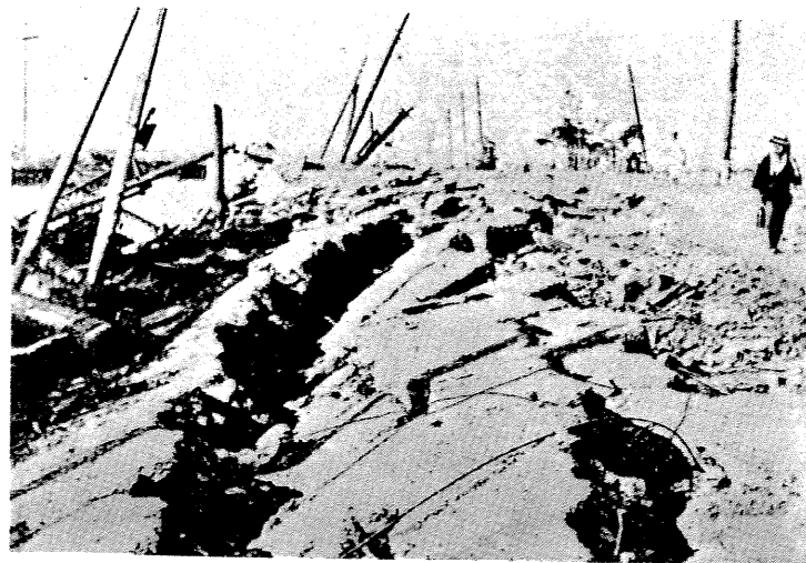
横濱市 足曳町附近被害状況
