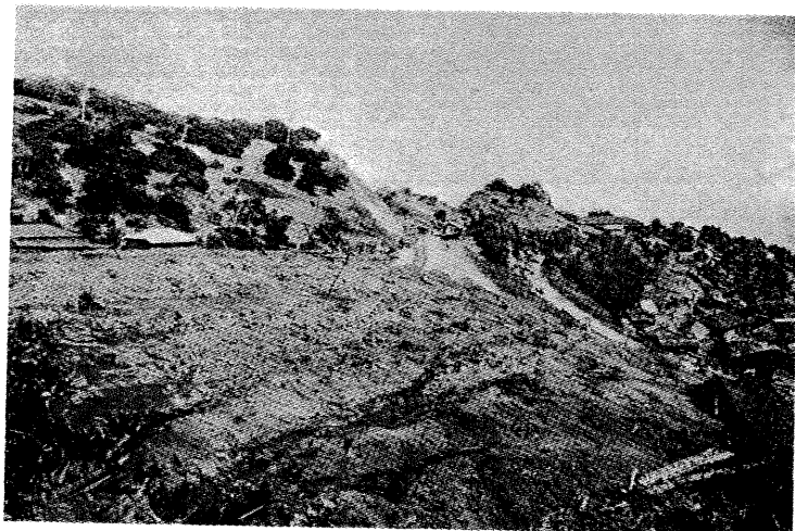
神奈川縣 根府川村被害狀況
