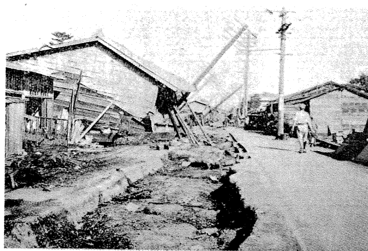
神奈川縣足柄下郡 小田原町被害狀況
