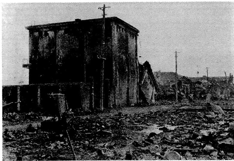
東京市京橋區越前堀 三菱倉庫アンビーフ式鐵筋混疑土造二階建但し一階柱は山形鋼4枚をラチスせるものに混疑土打ちたるもの右手に見ゆる殘存部分は平版構造崩壊の一般狀況
