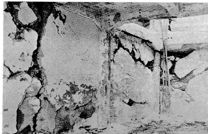
東京市麹町區錢瓶町 三越別館一階中央部間仕切壁の被害
