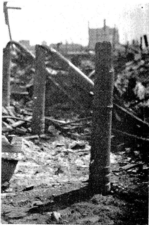
東京市日本橋區 魚河岸鑄鐵管柱の壊折状況
