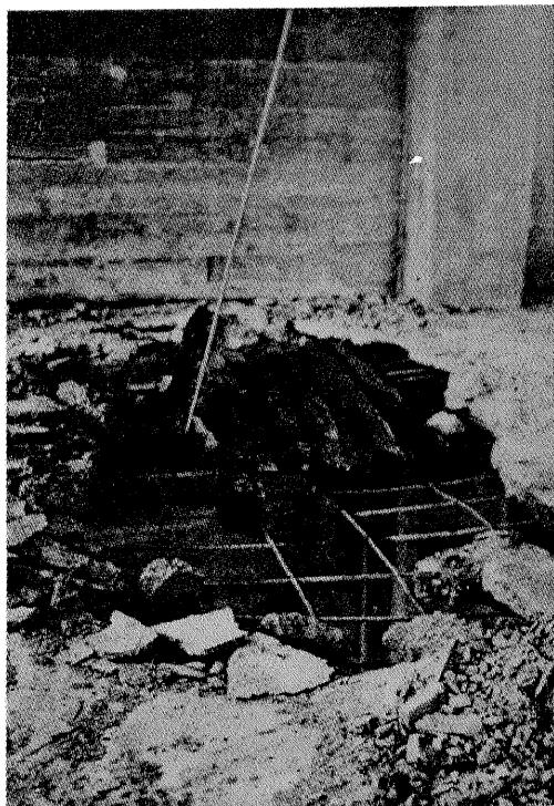
東京市京橋區銀座通 鳩居堂商店（鐵筋混凝土造三階建）三階床版の穿孔
