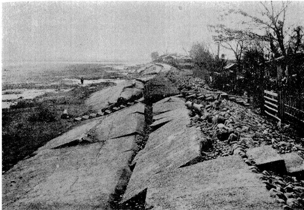
相模川右岸 厚木町地先鐵筋混泥土護岸の被害 (其二)
