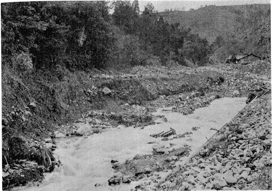
鮎澤川筋須川通り 静岡縣駿東郡小山町藤曲菅沼護岸石積の崩壊並に床固木工沈床の殘存
