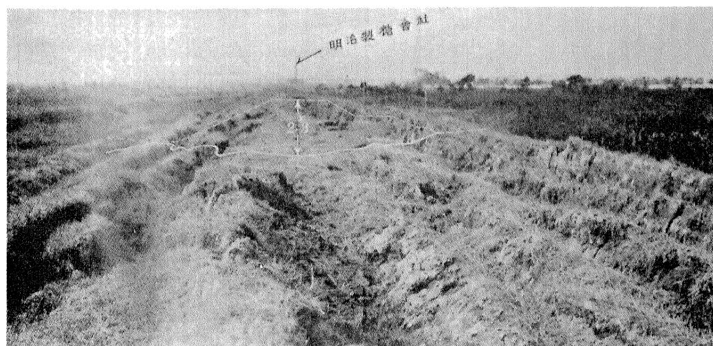
多摩川 東京府荏原郡六郷村八幡塚段功新堤陥落の状 (断面第39号より上流を望む)
