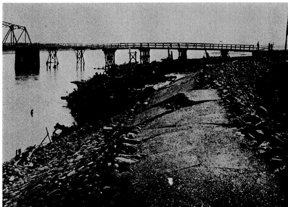
相模川右岸 厚木町地先鐵筋混凝土護岸の被害（其一）
