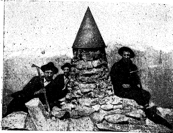
第 875 圖 Monte Leone 三角點視標 (Simplon Tunnel 三角測量)
