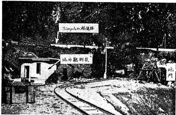
第 889 圖 Simplon Tunnel 南口假設導坑及び坑外觀測臺
