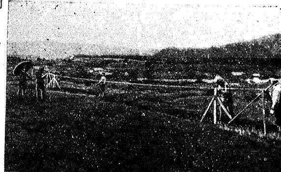
第 655 圖 アエバノ 饗庭野に於ける基線測量の状況
