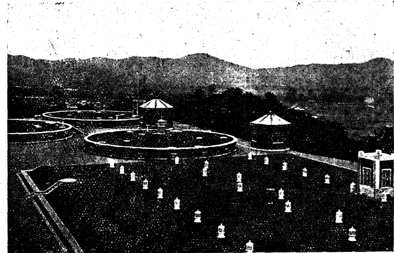
第156圖 岡山市水道配水池
