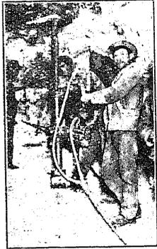
シ掘鑿機械ヲ有効ニ運轉セシメ得ルモノタルヲ要ス最モ有効ナル岩石掘鑿法ハ動力穿孔機 (Power drill) ヲ用フルニ在リ其動力トシテハ空氣力又ハ水力ヲ利用ス蒸氣力ハ直接ニ穿孔機ヲ運轉スルニ用ヒ得レドモ狭キ坑道内ニ於テ熱濕氣煤煙ヲ發スル等ノ種々ノ不便有ルヲ以テ直接ニ動力トシテ用ヒラルルコト稀ナリ電
